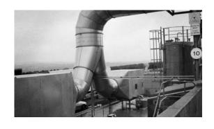
紧凑型霍斯利空气洗涤器,使您能够控制来自 炼脂操作的空气流的湿度水平,并将杂质(固体 颗粒物和灰尘)冲洗出来。
