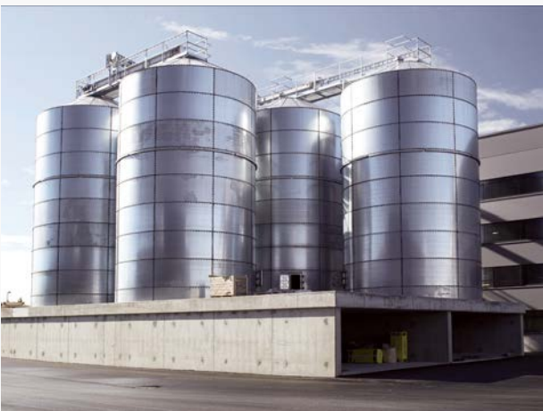
Silo de stockage
